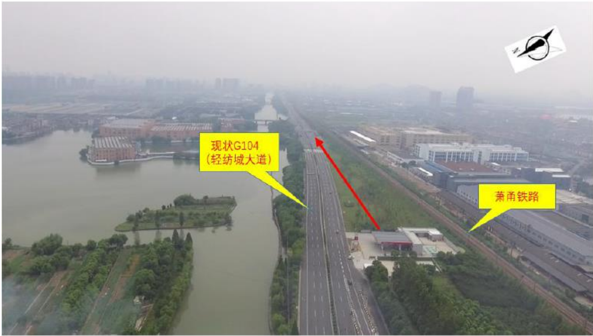
图 2.2-9 现状 104 国道（轻纺城大道段）航拍图
