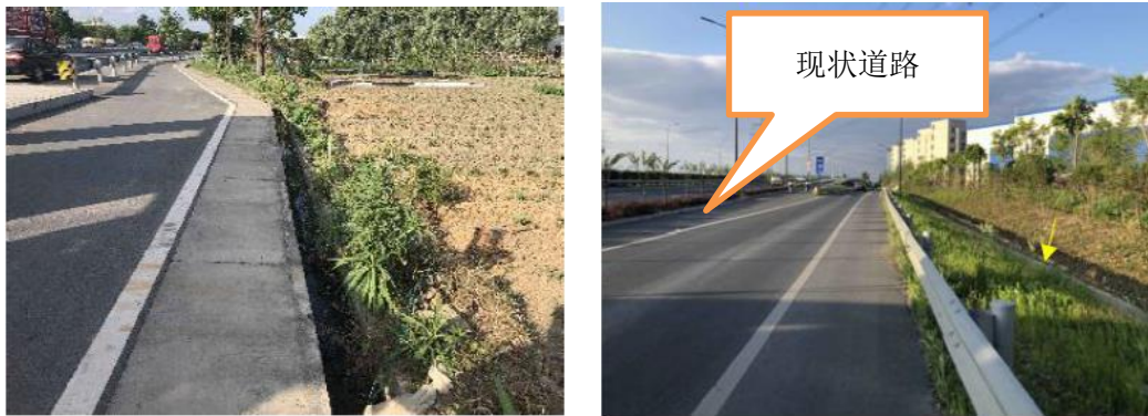
图 2.2-8 湖安路防护工程、排水工程现状照片
