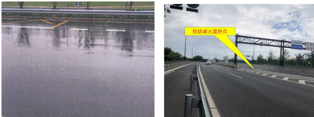
图 2.2-12 轻纺城大道路面现状照片
