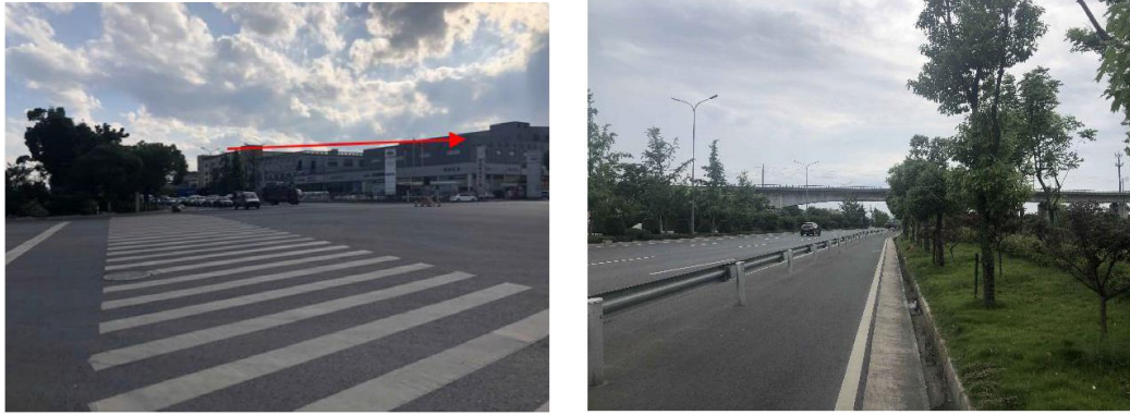
图 2.2-7 湖安路路面现状照片
